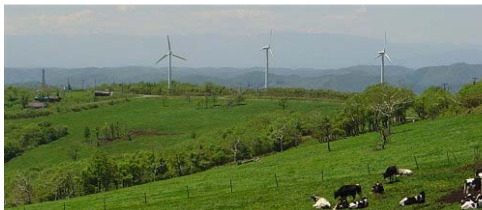
岩手県葛巻町袖山高原風力発電所 (1, 200 kW ; 400 kW 風車 × 3 基)
