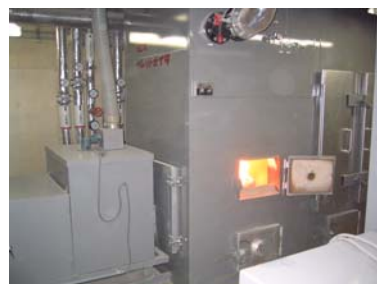
●ペレットボイラー (アットホームくずまき) 1 時間当たり 500,000 キロカロリー × 2 基、 平成 15 年整備
